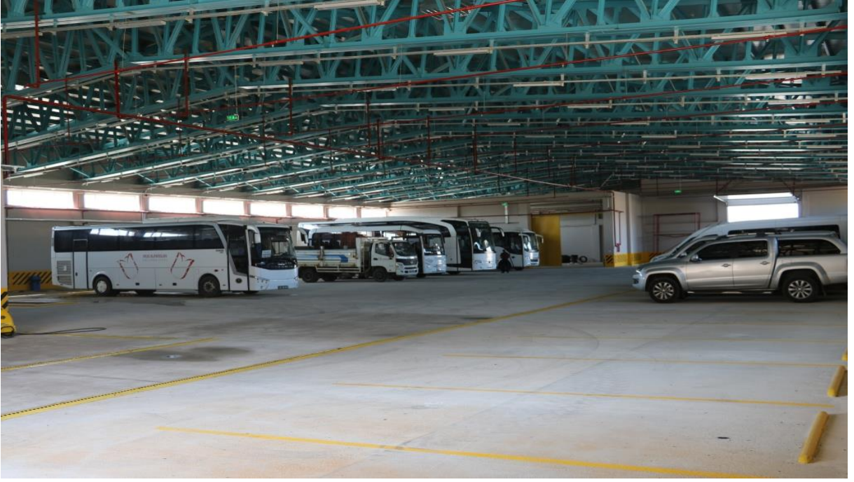
Resim 4. Hangar İç Görünüm
